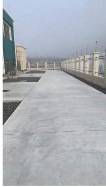
图6-8 变电站内路面硬化
