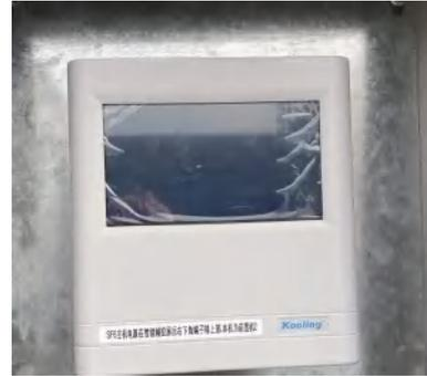
图6-4 SF<sub>6</sub>泄露报警仪
