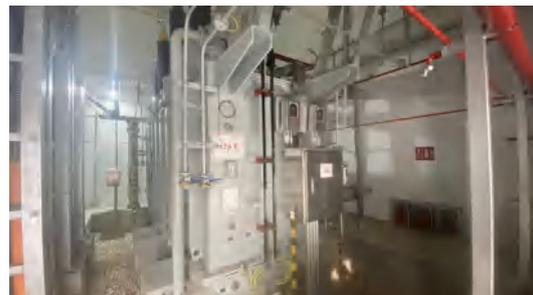
**图 4-8 2#主变压器**
